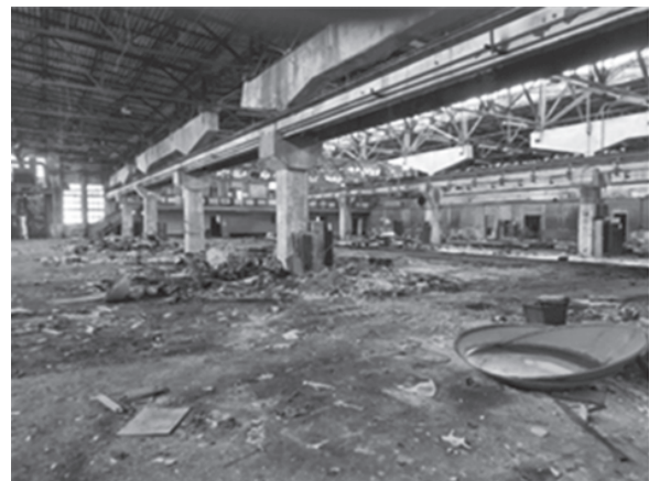
Рис. 1. Общий вид помещения производственного корпуса
