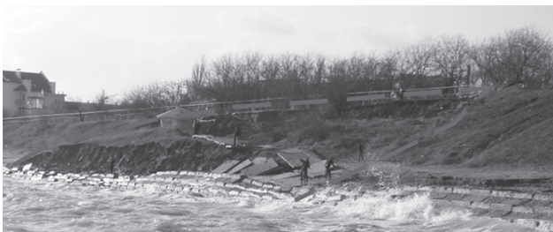
Рис. 8. Инженерно-геологический профиль I–I (а) и общий вид оползневого участка (б) (цитируется по работе [22])
