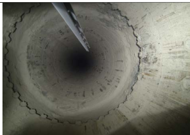
Рис. 7. Контакт нижней части обсадных труб с твёрдыми вендскими глинами
