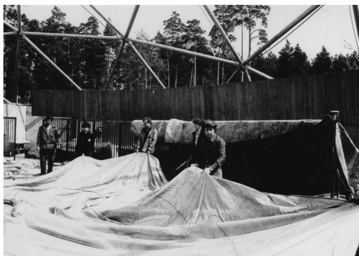
**Рис.14.** Передвижение периферийной части МО к центру площадки купола
