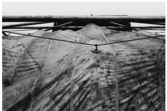
Рис.3 Крепление тарельчатой подвески к тросу.
