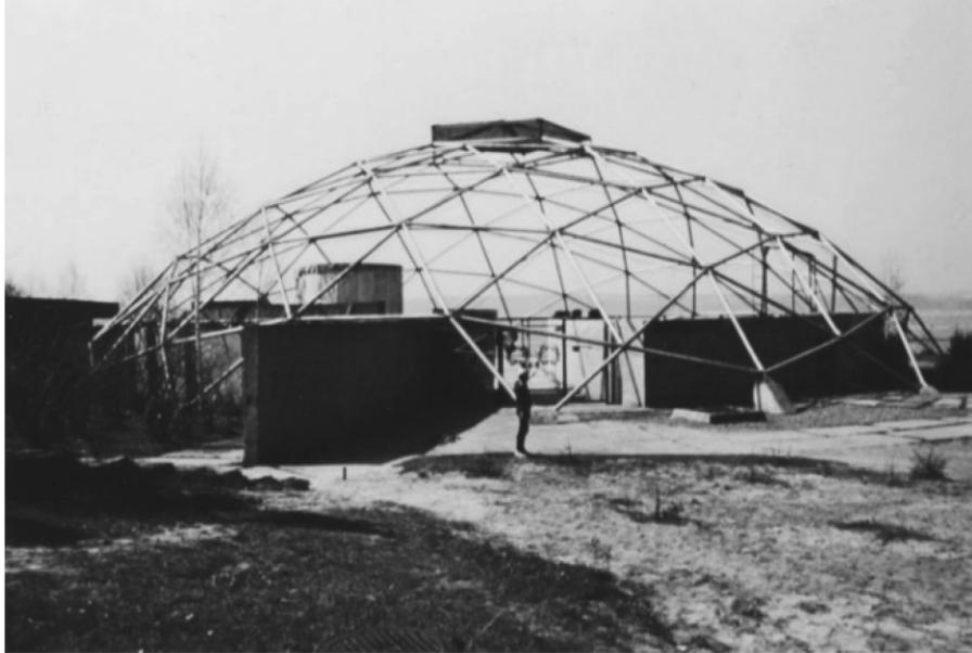
Рис.1 Каркас пространственно-стержневого купола.
