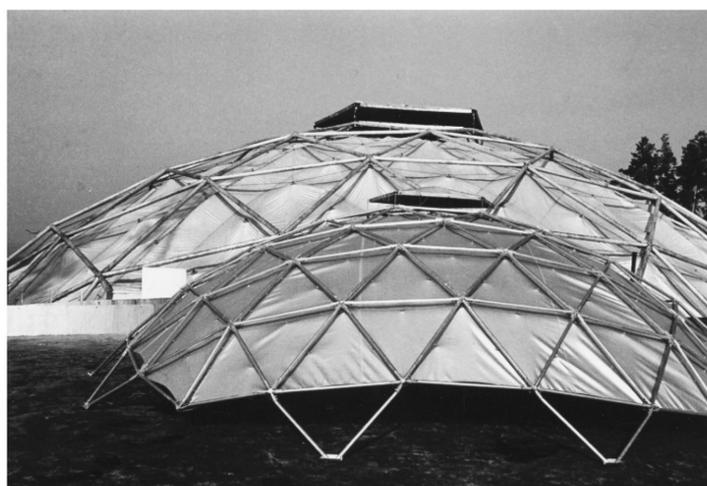
**Рис.15** Монтаж системы стабилизации и предварительного натяжения «МО» с помощью капроновых фалов диаметром 12 мм, уложенных между точечными подвесками. Тип конструкции в эксплуатации
