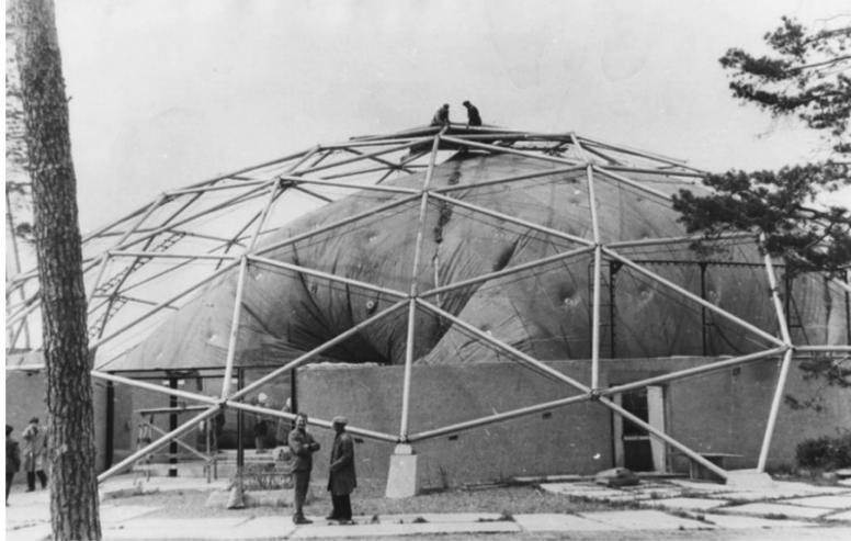
**Рис.9** Крепление точечных тарельчатых подвесок к стальным тросам по периферии зенитной части на натурном каркасе купола. Вариант №1
