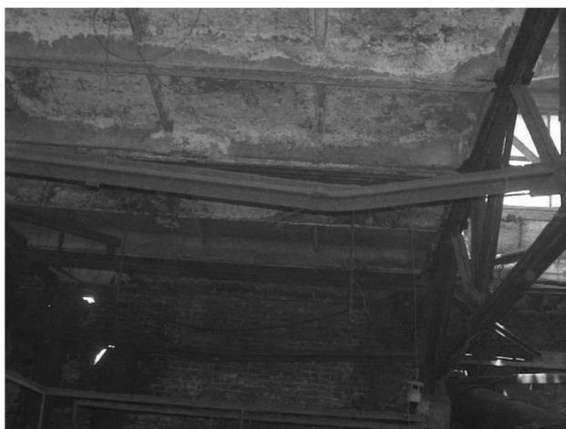
**Рис. 5.** Нижние пояса двух распорок погнуты вследствие механических воздействий при монтаже технологического оборудования ОАО «Ростоввводпром» г. Батайск.
