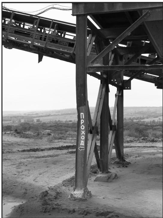
**Рис. 1.** Деформация двутавровой опоры цеха первичной сортировки дробильно-сортировочного завода х. Верхний Потапов
