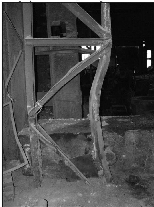
**Рис. 3.** Разрушение опорной части вспомогательной колонны технологической площадки ЗАО «Азовский кузнечно-литейный завод»
