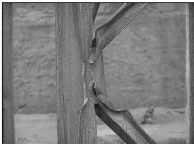
**Рис. 2.** Деформация опоры цеха сортировки мелких фракций дробильно-сортировочного завода х. Верхний Потапов
