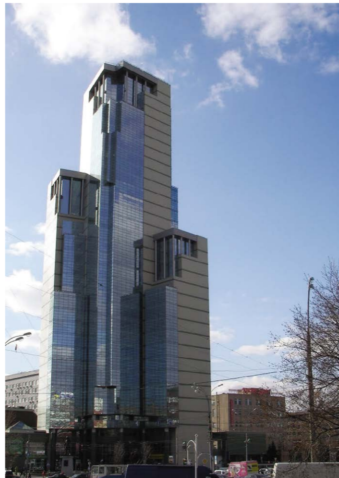
Рис. 4. Общий вид построенного здания.
