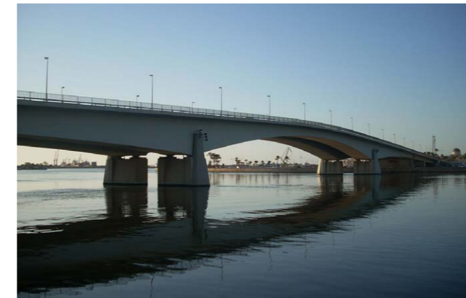
Рис 1. Мост GIULIANA в Бенгази, Ливия.
