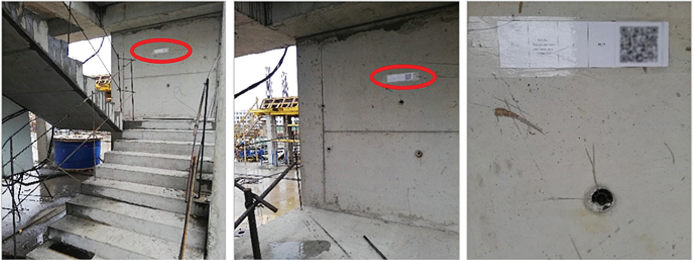
Рис. 16. Этикетки с QR-кодом на объекте Fig. 16. QR code labels on the object
