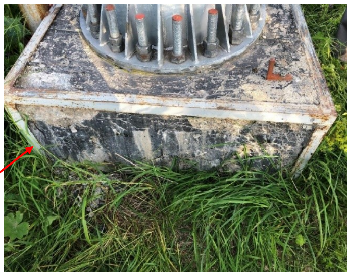
Рис. 3. Верхний уступ фундамента, выполненного с использованием анкерных микросвай
