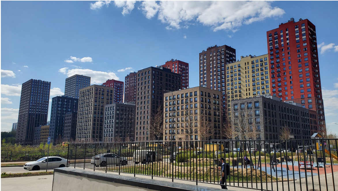
Рис. 1. Современные высотные здания (фото Стариковой А.С.)
